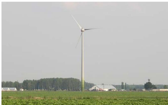
3.1. ábra Szélerőmű, Erk településen (Enercon E-48, 800 kW, 76 m) (forrás: saját felvétel)
